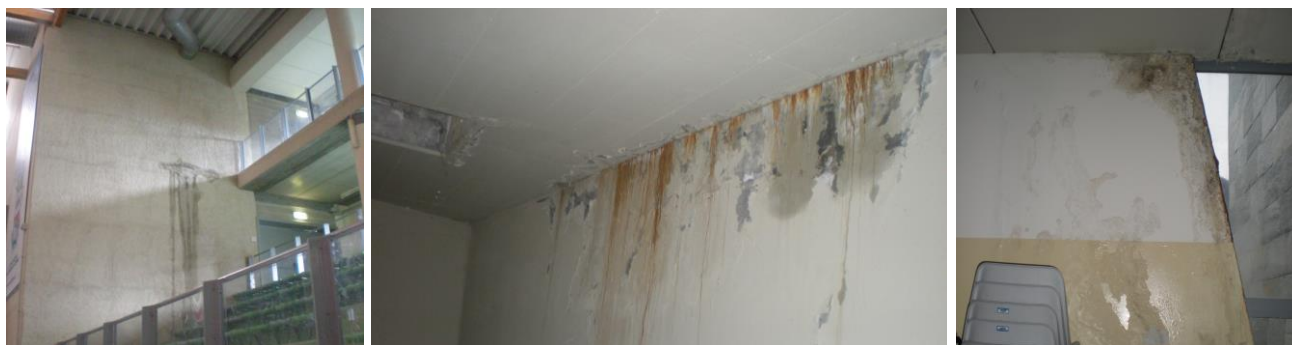
Palaghiaccio - pareti danneggiate a seguito delle infiltrazioni
